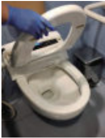
① トイレ便座をあげる
